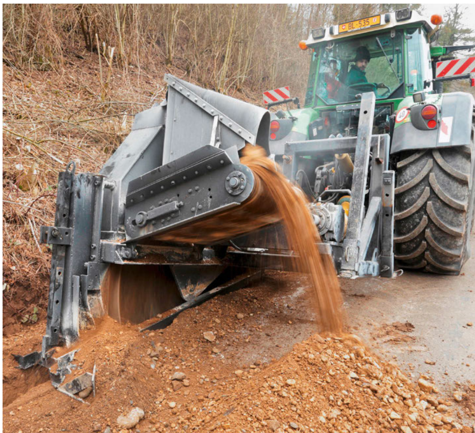
Lucas Huber Weit schneller als mit dem Bagger zieht die Fräse einen präzisen Graben.
